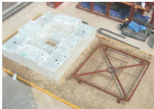
> 모래판과 Template 및 철근 선조립 작업 전경
