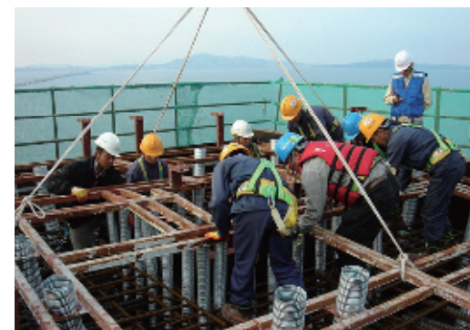
쉬스관 위치 고정용 template 설치
