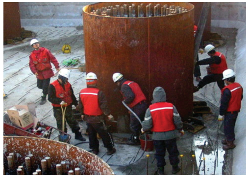
> 급결 콘크리트 타설 및 PC House 가설 완료
