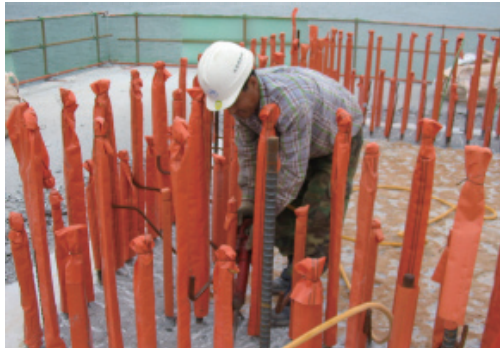
> 신규 콘크리트 접합면 Chipping 작업
